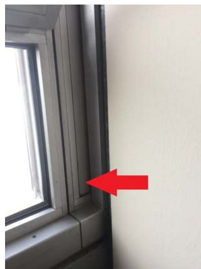
Halb verdeckt durch Zwischenwand
