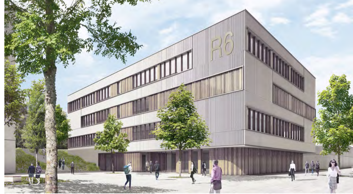
Der Neubau R6 ist Teil des Ende 2019 vorgestellten Standortkonzepts Campus Süd, das die Einbindung der baulichen Umsetzung der Medizinischen Fakultät in den Campus Bielefeld betrachtet. Insgesamt werden in den kommenden Jahren sieben Bauvorhaben für die Medizinische Fakultät realisiert.
